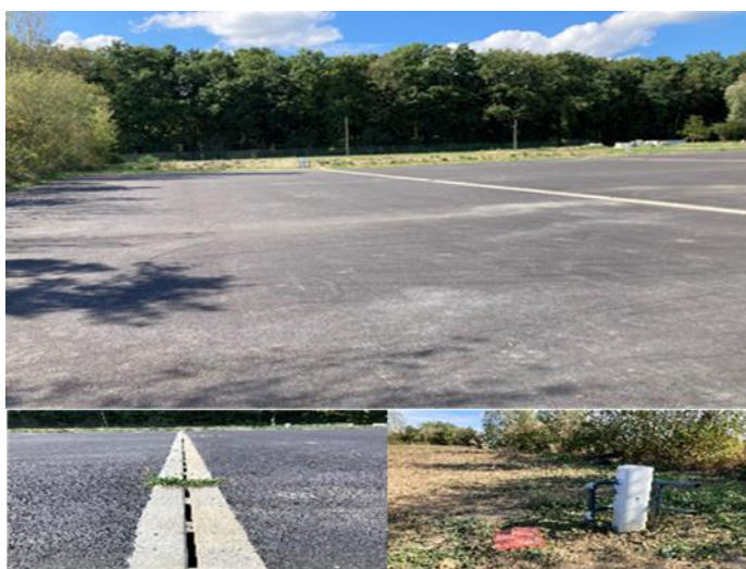
Aire de petits passages. En bas à droite, une borne pour l'électricité et une borne pour l'eau (en rouge). En bas à gauche, système pour évacuer l'eau pluviale.
